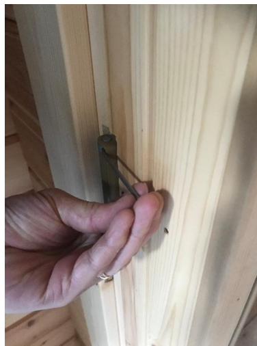
Ta spännarpinnen och stoppa in den i hålet som syns på gångjärnet
