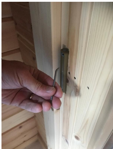
Ta spännarpinnen och stoppa in den i hålet som syns på gångjärnet
