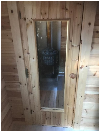
Dörr monterad med foder runt om.
